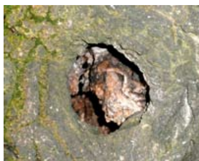
Auch Nisthöhlen werden vor einer Maßnahme untersucht
